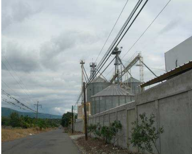
Planta de asfalto en Villa González
