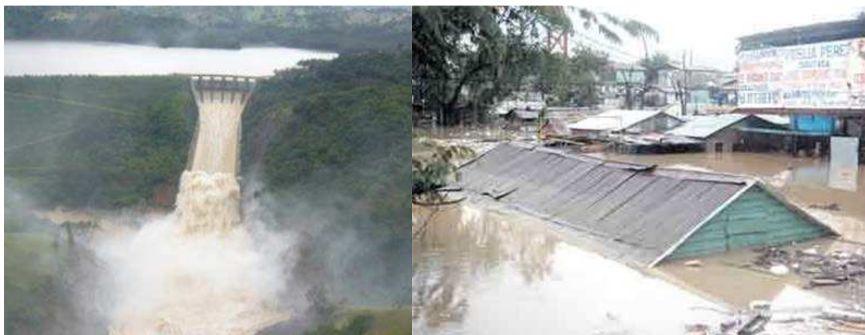
Foto 13. Vista del desfogue de la Presa Taveras en el 2007 durante la Tormenta Olga e inundaciones en la Provincia Santiago.
