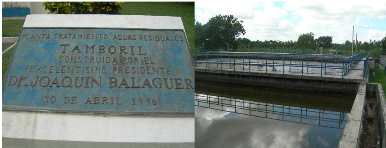
Foto 4. Vistas de la Planta de tratamiento de Tamboril visitada durante la presente caracterización.
