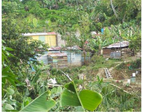
Descarga del Barrio La Cancha al Arroyo Pinto
