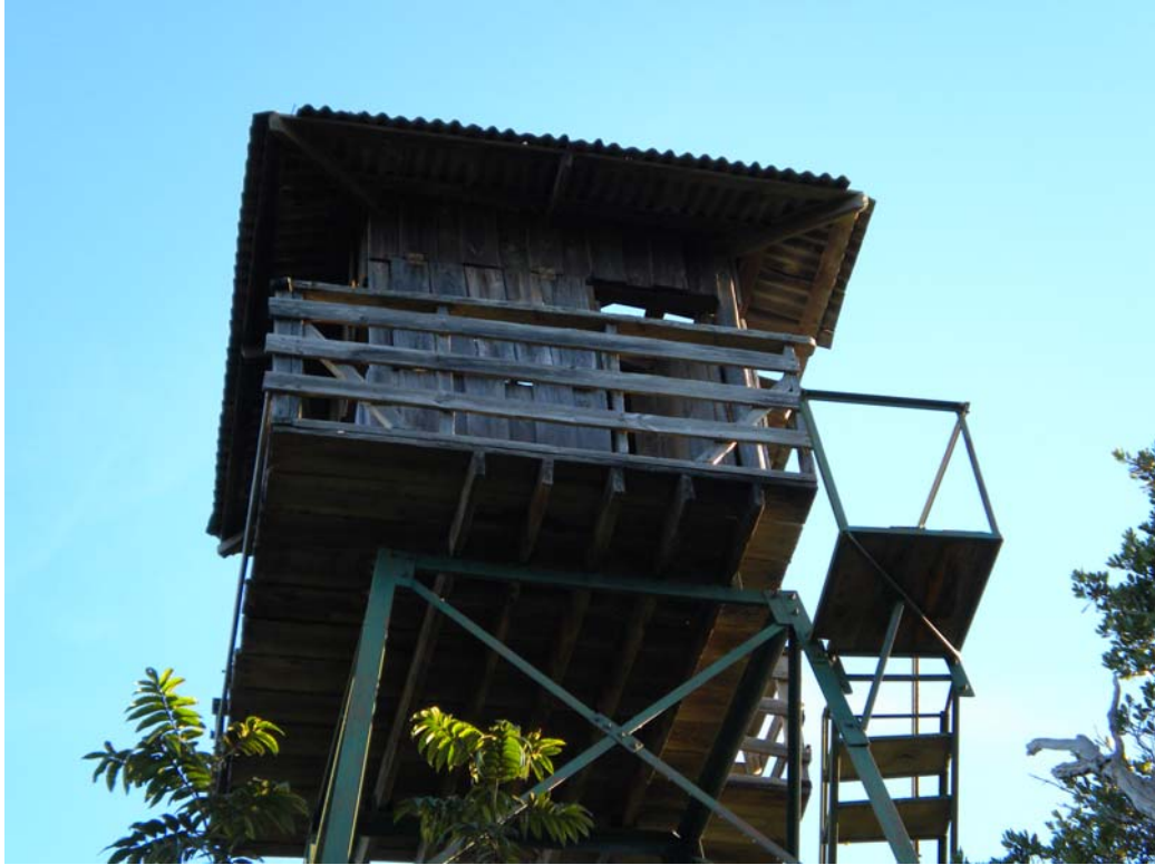
Foto No. 1. Vista cercana de la caseta de la Torre Los Platicos
