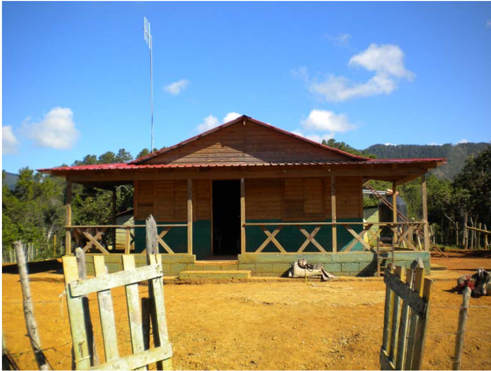
Foto No. 30. Caseta próxima a la Torre Alto de la Rosa
