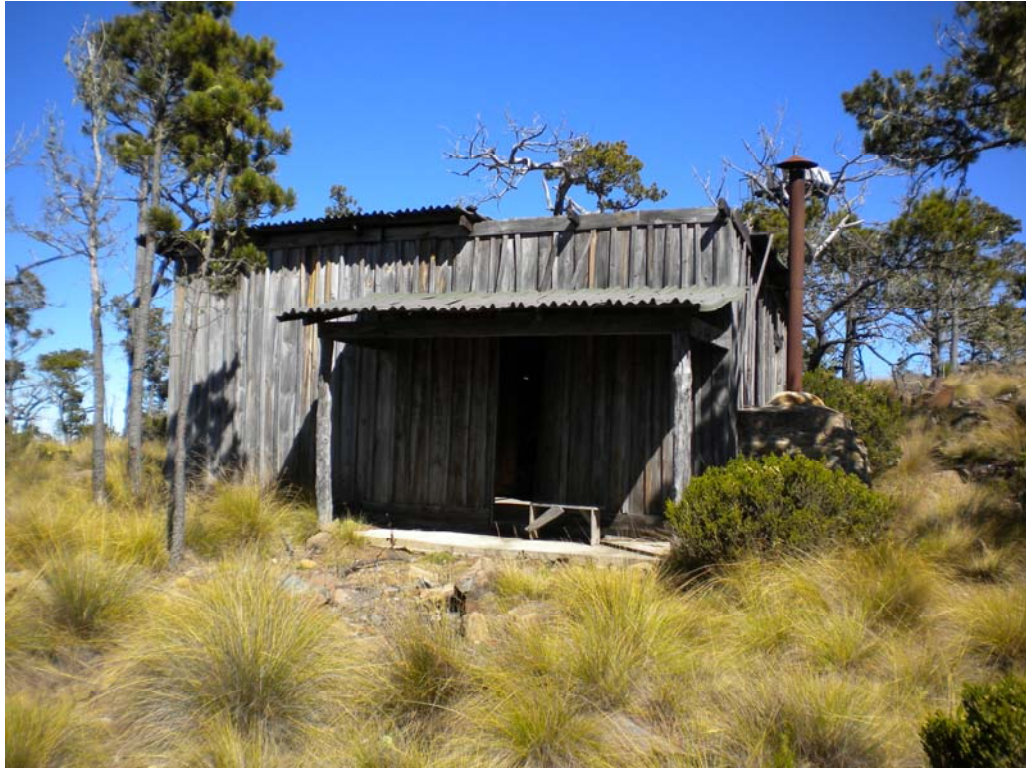
Foto No. 17. Caseta de abajo de la Torre La Pelona
