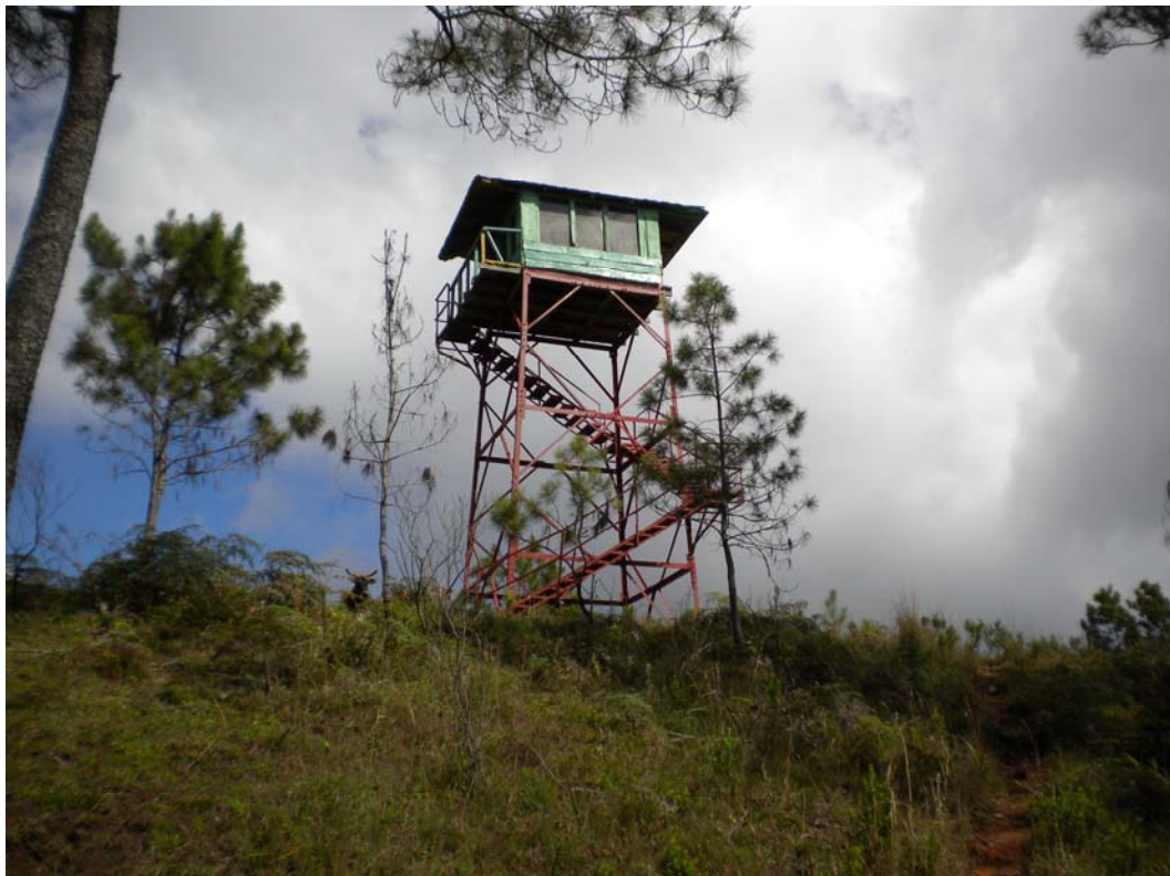
Foto No.24. Vista de la Torre La Cruz del Negro
