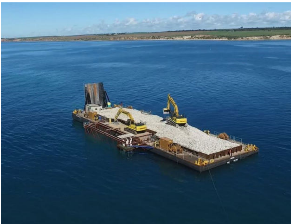
Una barcaza de construcción descarga rocas para la restauración de un arrecife (véase el Recuadro 1 para más detalles). Australia. Foto: Adam Bolton.
