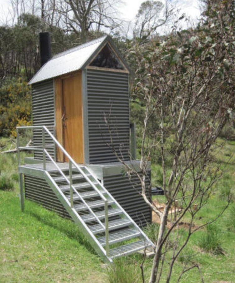
Sanitario de diseño contemporáneo con un manejo de residuos del tipo fly-out en el área de acampar de Dibbin Hut, con el cual se reemplazó la antigua letrina, Parque Nacional Alpino, Victoria, Australia
