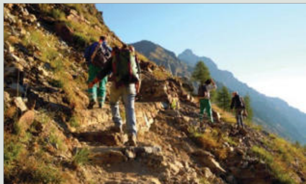
Reconstrucción de un sendero antiguo en el área protegida transfronteriza de Alpi Marittime-Mercantour, Italia
