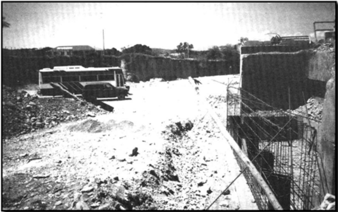
Foto No.8 Nueva carretera y puente Azua-San Juan
