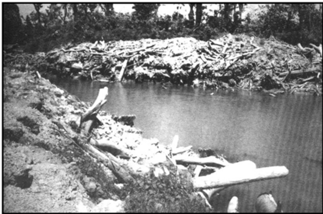
Foto No.9 Espesor de sedimentos en Río Yabón. Sabana de la Mar.
