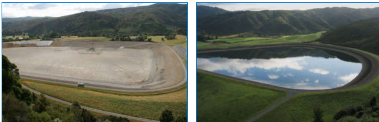
Figura 4: Estructuras de Aprovechamiento de Aguas Lluvias (Reservorios)
