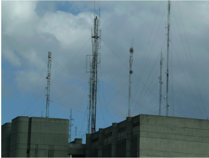
Exceso de antenas de comunicación en la ciudad de Santo Domingo. Fuente: Antonio Matarranz.
