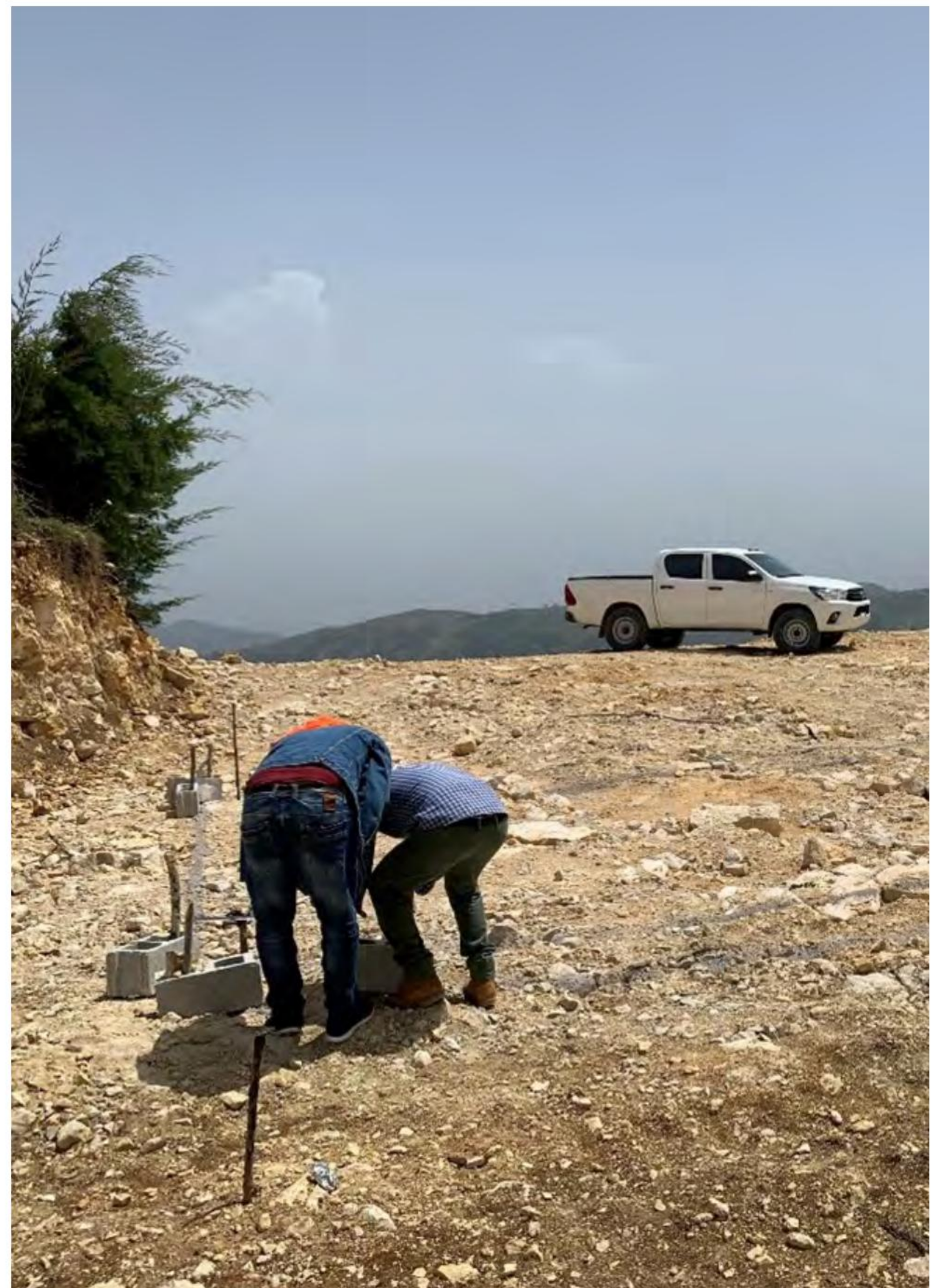
Trabajos de definición de las cimentaciones en el terreno de la microcentral fotovoltaica en Sabana Real.
