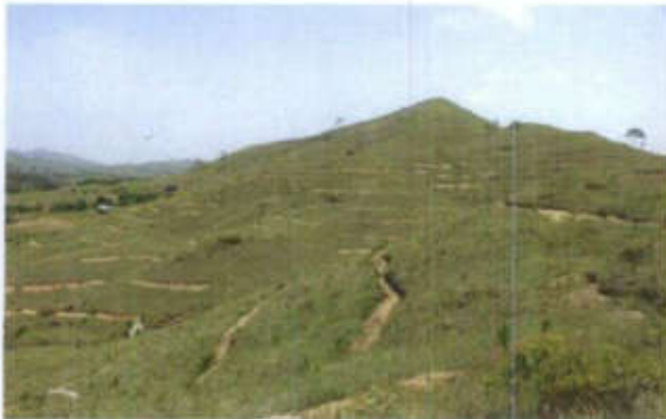
Construcción de zanjas de infiltración
