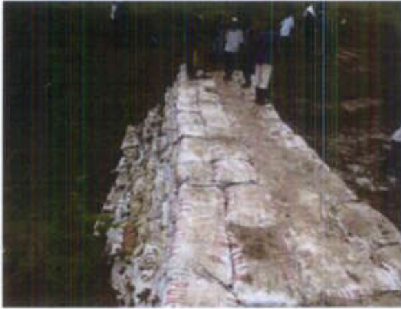
Construcción de diques
