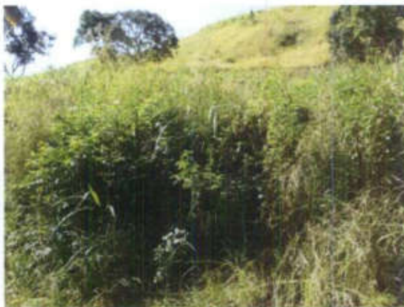
Dique construido 13 meses después (actual)
