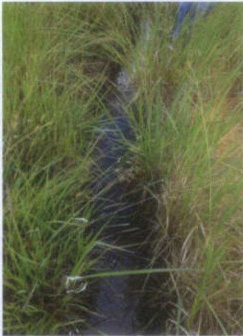
Cobertura de las zanjas 8 meses después
