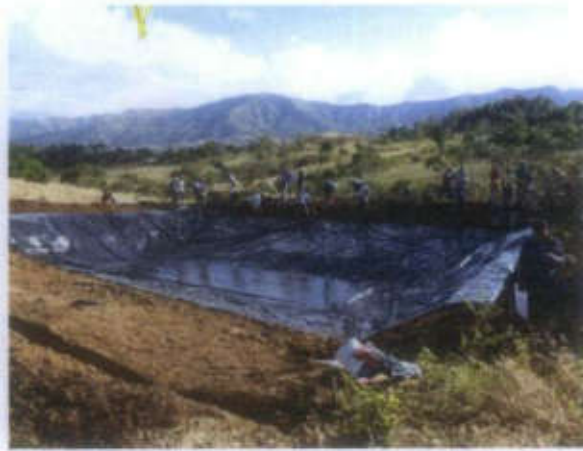
Revestimiento de reservorios
