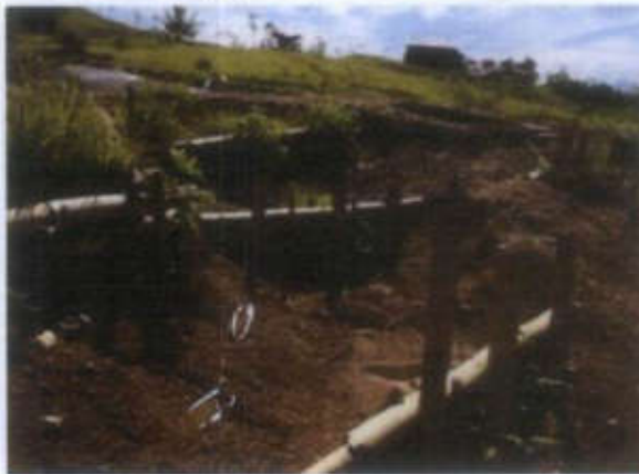
Reforzamiento de reservorios con bambú y piñón cubano, 6 meses después
