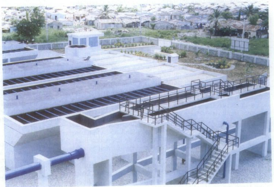
Vistas de la Planta de Tratamiento de Aguas Negras, en La Ciénega.
