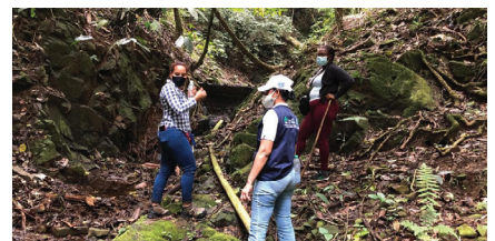
Essai de pompage de l'eau pour mesurer le débit fourni pour alimenter le réservoir de stockage de l'eau en cours de construction pour l'aqueduc de la communauté de Loma Verde, l'un des nombreux conçus pour alimenter les zones rurales.
