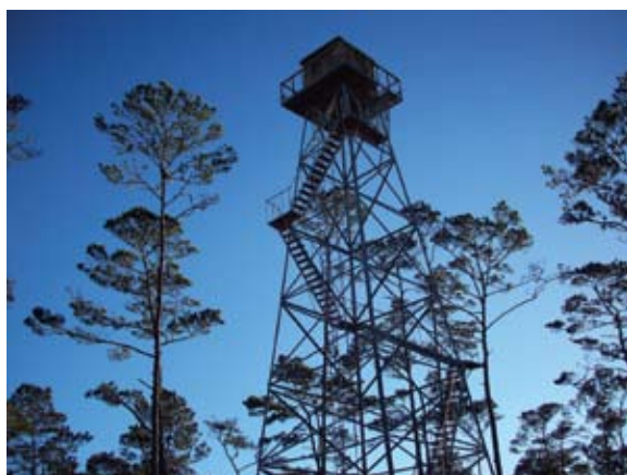
Torre de control de incendios
