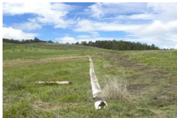
Tuberías extraídas, Nizaíto, 2011
