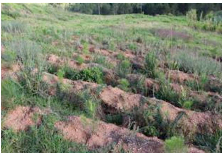
Trabajos de rehabilitación, Comunidad El Castillo, Aguas Blancas, 2012.
