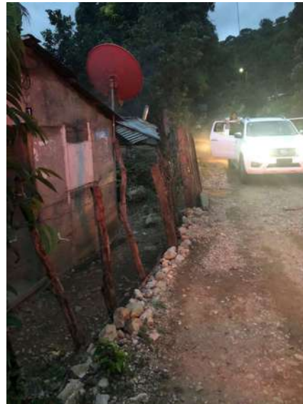
Ejemplo de ocupación del derecho de paso por vivienda (Ingenito)
