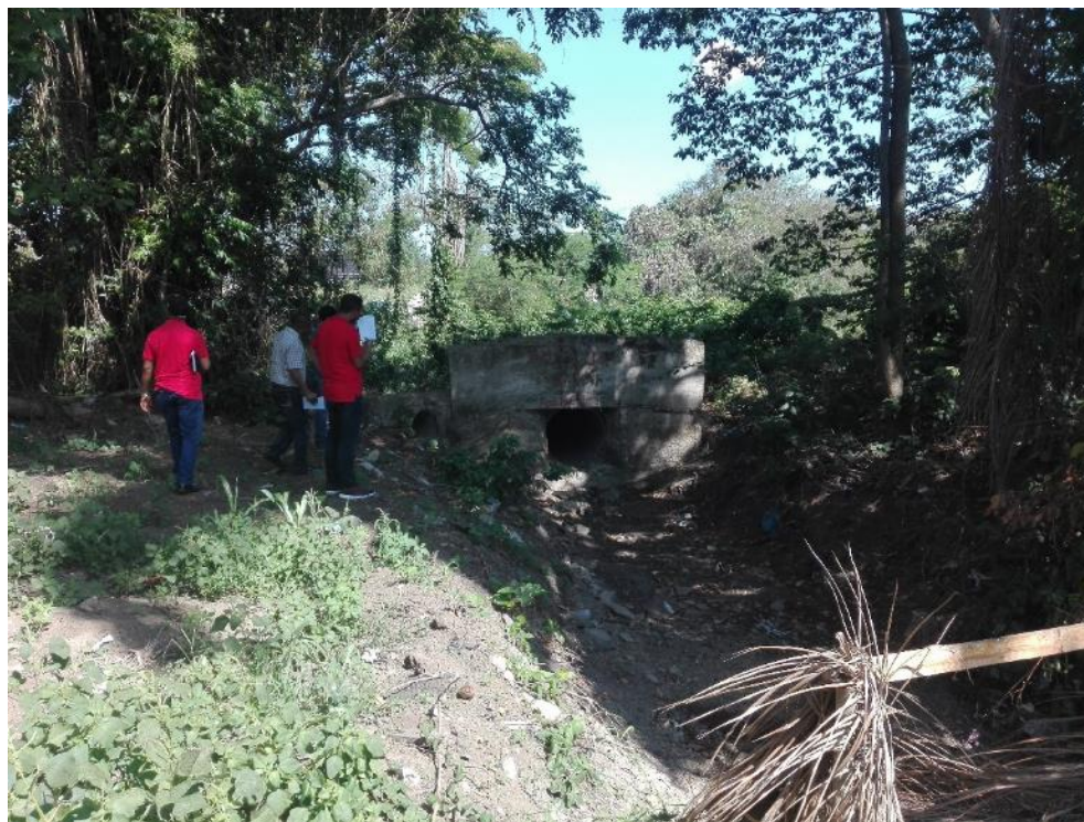
Figura 5-8: Fotografía de la cañada, Terreno de la Regional La Vega
