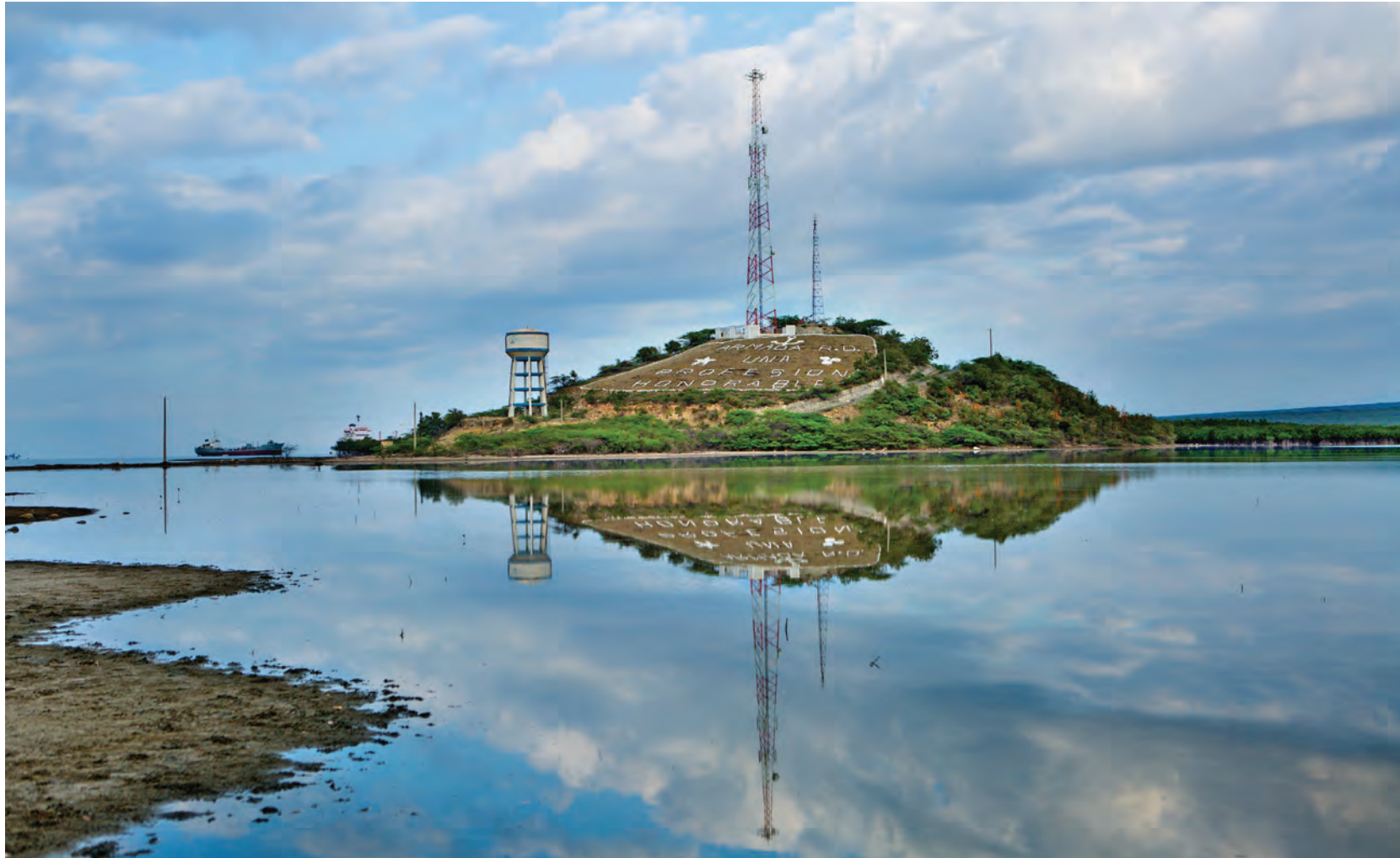
Base Naval de Las Calderas.
