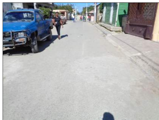
Calle de la zona urbana del municipio de Vallejuelo.
