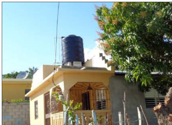
Foto 6-9. Tinaco para almacenar agua en vivienda de la comunidad de La Colonia del municipio de Vallejuelo.
