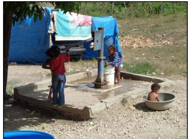
Foto 9.3-2. Extracción manual de agua en pozo tubular en Los Baos
