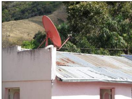
Vivienda con telecable en la Sección Río Arriba del Sur.
