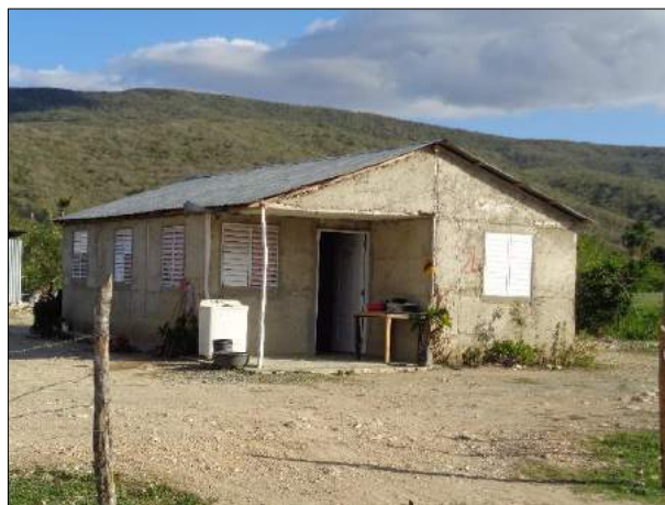
Fotos 5.1-2. Viviendas en el distrito municipal de El Rosario con paredes de block o concreto, tomadas en enero 2016.
