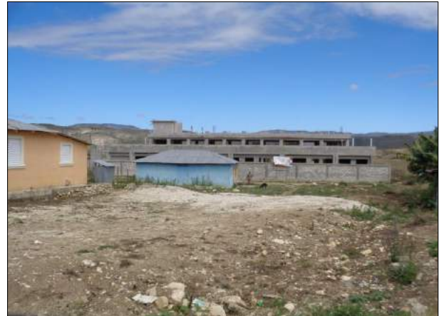
Foto 2.7-1. Escuela en construcción en el distrito municipal Batista.
