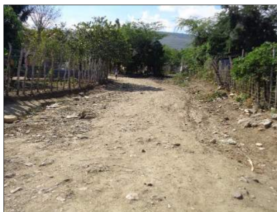
Camino Vecinal de la Sección Cardón del distrito municipal El Rosario.
