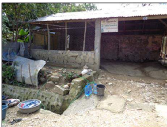
Foto 4-2. Abastecimiento de agua a través de llave en patio de vivienda, distrito municipal de Derrumbadero.
