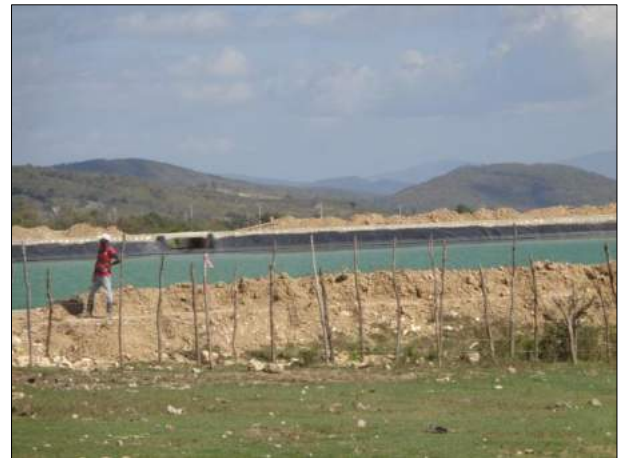
Foto 2.4-1. Imágenes del proceso de construcción del proyecto presa multiuso “Las Dos Bocas”.
