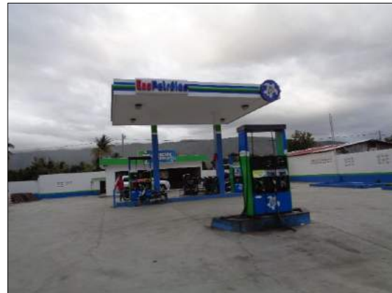
Foto 10.1-3. Expendio de combustible ubicado en la zona urbana del municipio de Vallejuelo.
