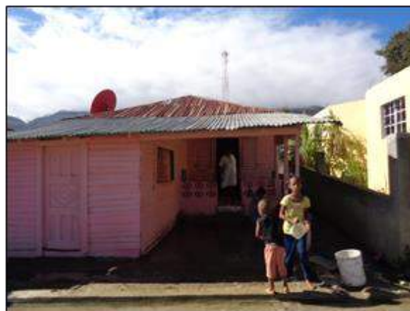
Foto 6-14. Uso de agua para limpieza en el distrito municipal de Batista.
