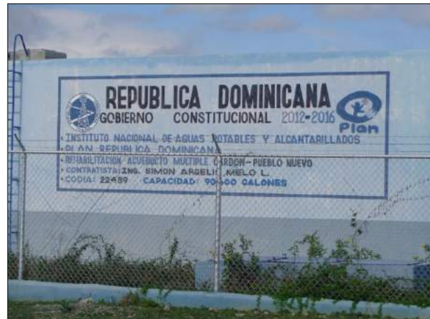
Foto 6.3-1. Acueducto Cardón-Pueblo Nuevo.
