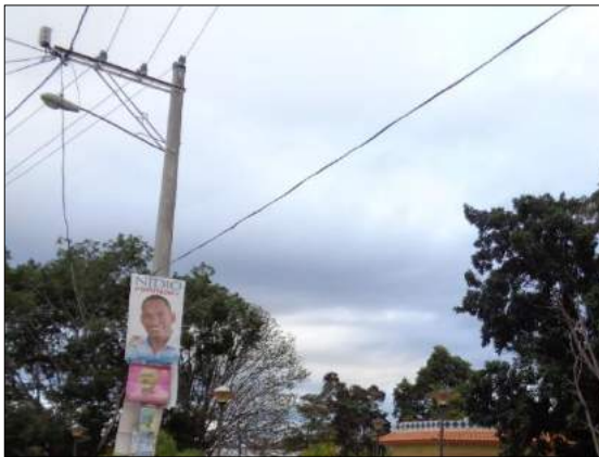
Tendido eléctrico en las zonas urbanas.
