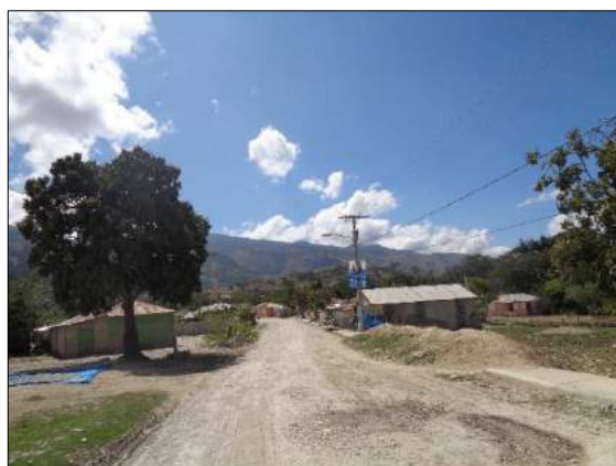
Camino Vecinal de la Sección Damián de distrito municipal de Derrumbadero.
