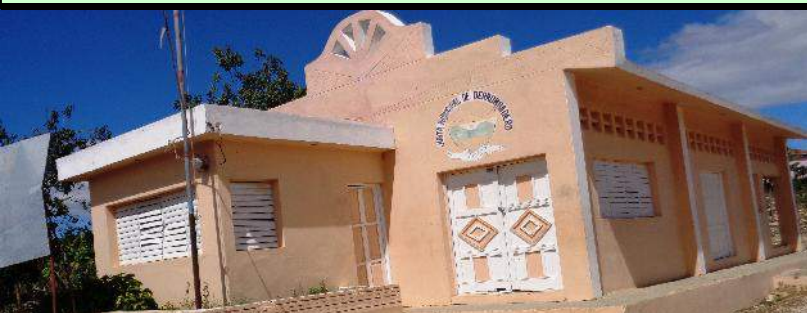
DERRUMBADERO, Junta Municipal.
