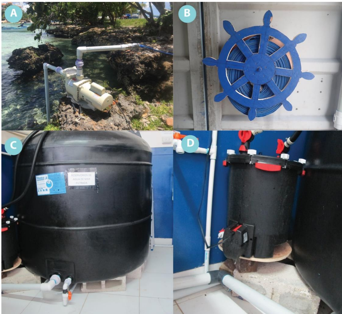
Figura 2. Sistema de llenado de agua. A) Bomba conectada a manguera flexible. B) Carrete para el almacenado de la manguera flexible. C) Reservorio de agua de 2000 L. D) Filtro de sedimentos (Canister Fx6).
