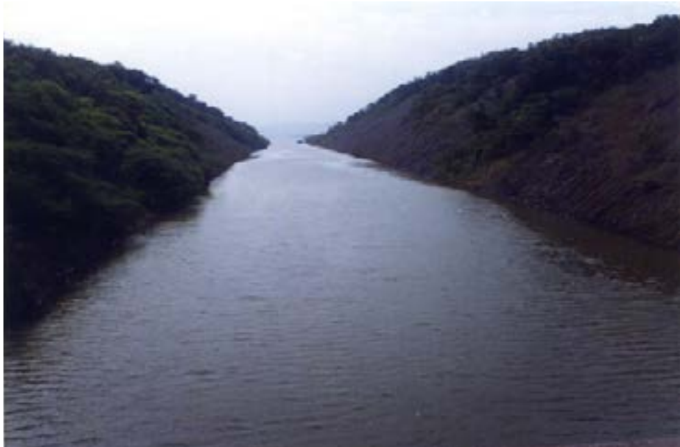
Fig. 5.15 CANAL DE COMUNICACIÓN CON LA PRESA DE TAVERA
