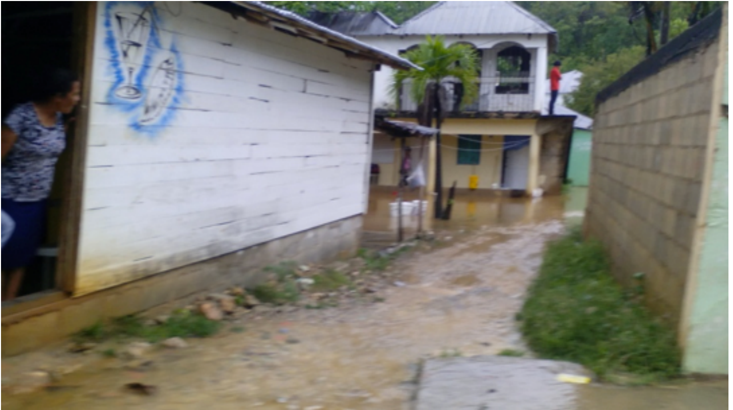
Imagen de una inundación reciente en el barrio El Hospital.
