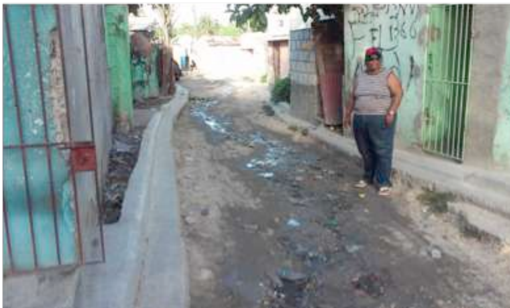
Es la entrada al hoyo, calle principal donde se aprecia el desperdicio de agua de INAPA
