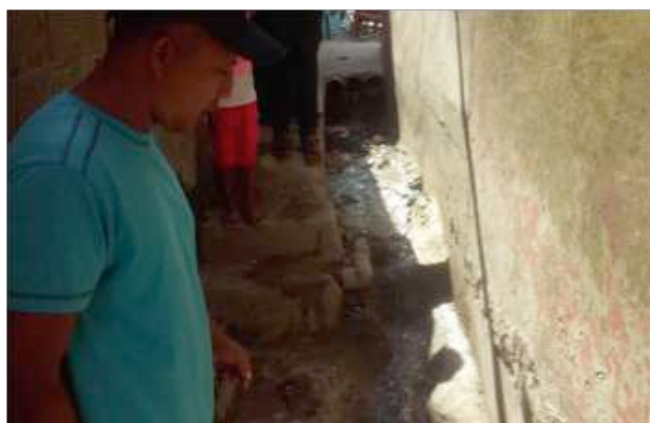
Vista Norte, Aguas residuales y desperdicios sólidos en la principal conexión al canal de desagüe principal que atraviesa Barrio Blanco 1 y Canta La Rana hacia el río Higuamo.
