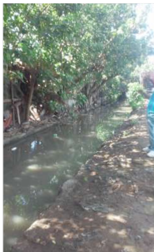
Parte final del canal que llega al río Higuamo. Se puede observar que la marea esta alta por lo incide en el nivel de las aguas residuales en el canal que tiene una profundidad de aproximadamente de 2m.
