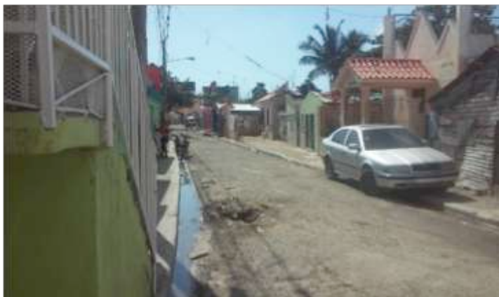
Vista Norte, Calle principal, colinda con la pared del cementerio el tamarindo. Es donde se concentra toda el agua pluvial hasya 8 pulgadas de espesor.
