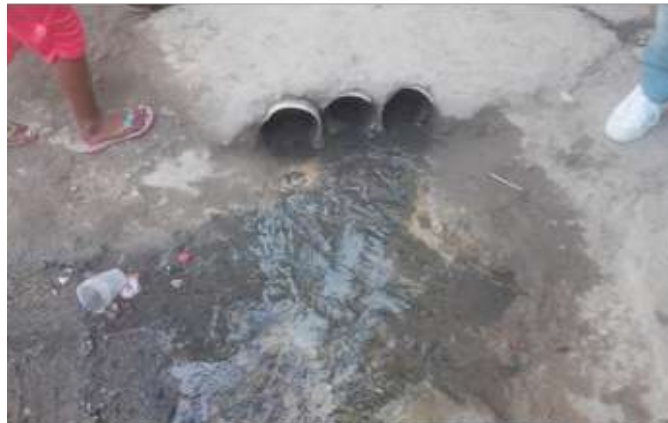
Vista Este, Calle Principal, colinda con la pared del Cementerio El Tamarindo. Aguas residuales en la principal conexión al canal de desagüe principal que atraviesa Barrio Blanco 1 y Canta La Rana hacia el Río Higuamo.
