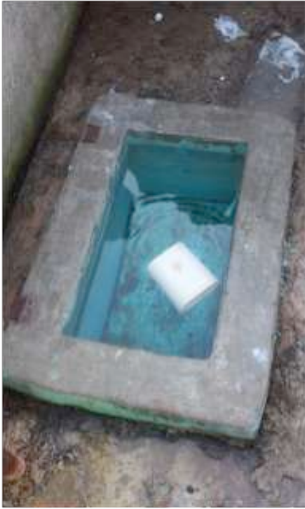
Deposito improvisado de agua proveniente del suministro de INAPA cerca del muro de contención del río Higuamo
