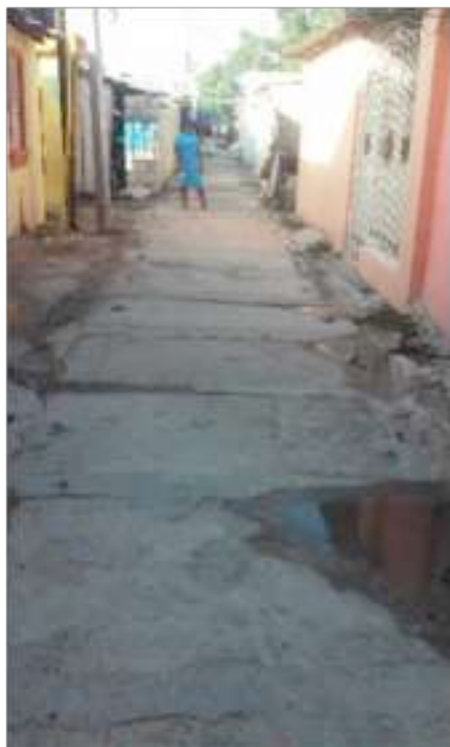
Vista del canal de desagüe pluvial para las aguas de los barrios en la parte este de la ciudad. Y donde están conectados todos los baños cercanos
