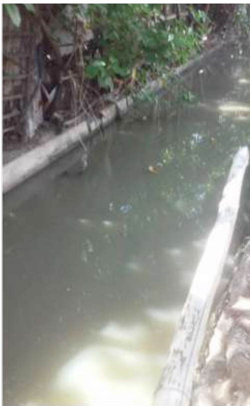
Parte final del canal que llega al río Higuamo. Se puede observar que la marea esta alta por lo incide en el nivel de las aguas residuales en el canal que tiene una profundidad de aproximadamente de 2m.
