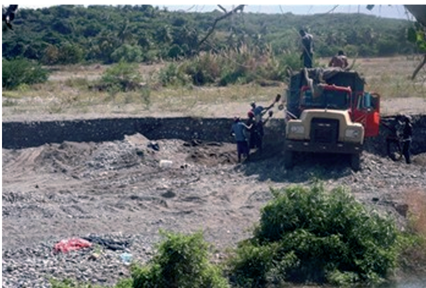
Fig.18. Paleros extrayendo arena y grava de la orilla de un río provocando un impacto negativo en el cauce del mismo.
