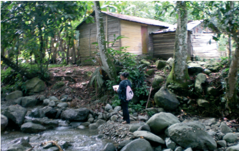
Fig.24. Vivienda rural con alto riesgo de inundación debido a su proximidad al cauce del río, en Jima, Bonaó, Rep. Dom. (Foto C. Díaz).
