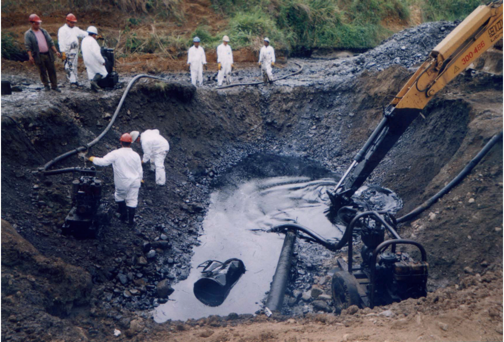
Fig. 46. Obreros extrayendo el petróleo derramado por la explosión de una tubería que transporta petróleo para Falconbrigde Dominicana, desde el Puerto de Palenque, San Cristóbal, hasta Bonaó, Monseñor Nouel, Rep. Dom. Foto cortesía de Zoraida Zapata.
