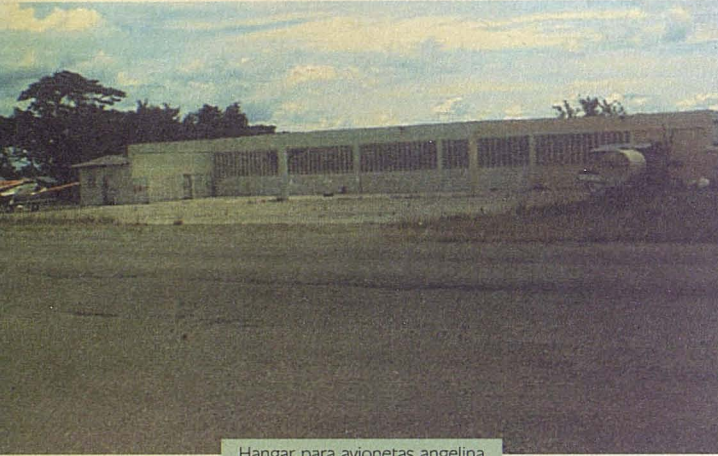
Hangar para avionetas angelina
