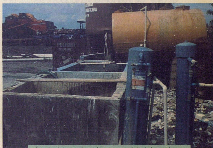
Área de almacenamiento de agua y mezclado de los productos
