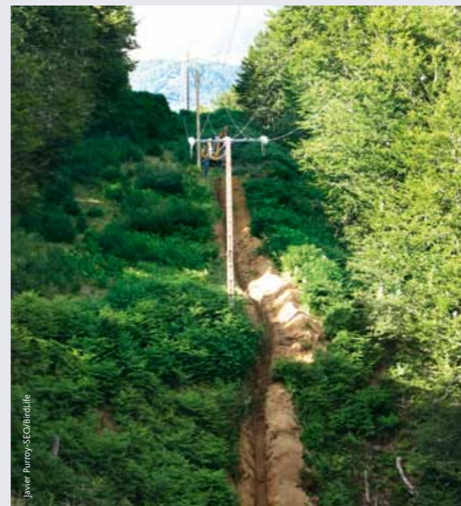
Obras de soterramiento de una línea eléctrica en Picos de Europa.
