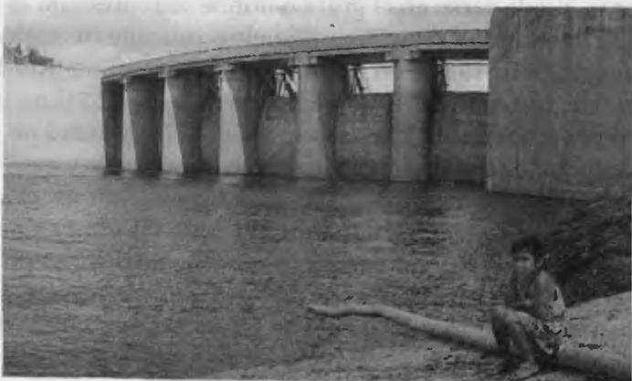
Vertedero presa de Tavera. Visto aguas arriba. Sirve para desaguar hasta 7,000 m<sup>3</sup>/s de los excesos de agua de los embalses de Tavera y Bao cuya capacidad de almacenamiento es 417 millones de m<sup>3</sup>.
