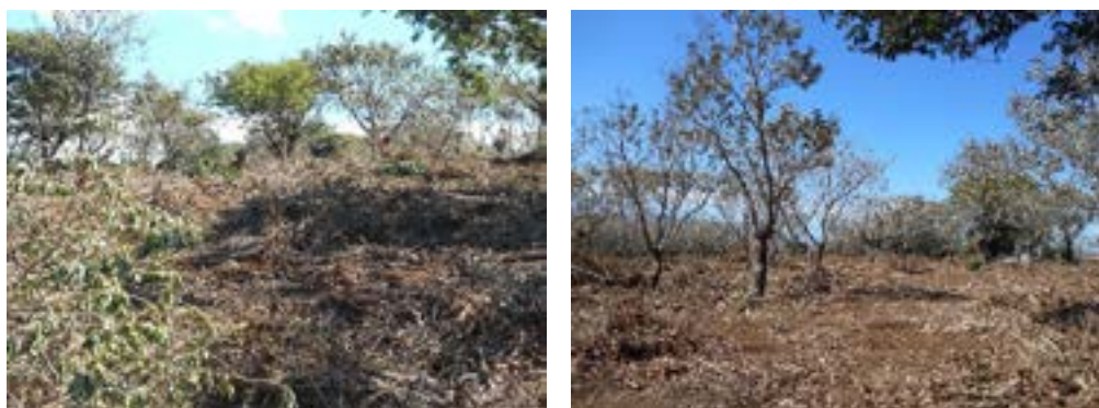
Figura 15. Preparación del terreno: ejemplo de un terreno antes de limpiarse y después.
