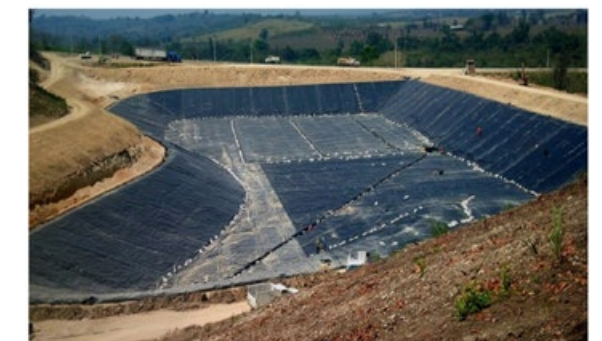
Figura N° 20. Modelo 1 de relleno sanitario a evaluar si se presenta en la zona objeto de estudio.
