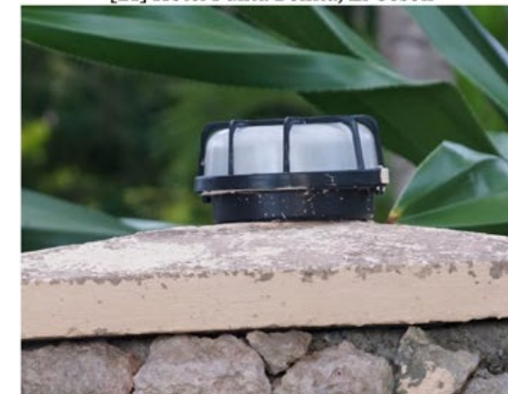
[07] Villa No. 3, Las Terrenas
