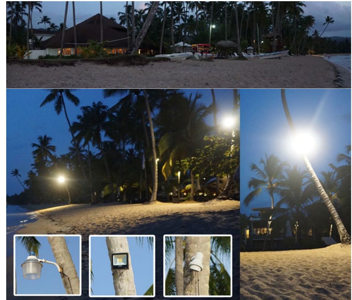
Figura No. 29. Vistas nocturnas de la playa en uso por los hoteles Sublime Samaná y Viva Wyndham con luminarias de poste, proyector LED o reflector aluminizado parabólico, que emiten una potente luz blanca.
