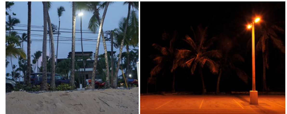
Figura No. 44. Izquierda. Vista nocturna actual del alumbrado público en la avenida 27 de Febrero en Las Terrenas. Derecha. Ejemplo de luminarias de alumbrado público con lámparas de color rojo amigables con las tortugas marinas en Tarague Beach, Guam. Fuente: https://www.af.mil/ .
