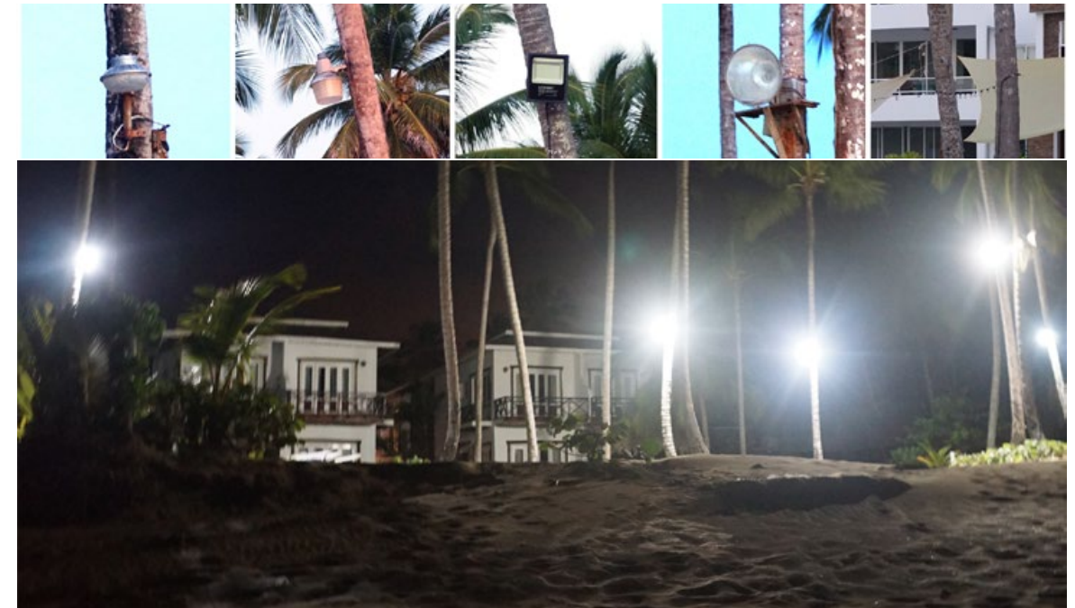
Figura No. 26. Vista nocturna de la parte trasera del Residencial Colina al Mar desde el mar con luminaria sobre postes y cocoteros en la playa. Arriba. Algunos tipos de luminarias inventariados: de poste con cubiertas transparentes cerrada y abierta, proyectores LED y de largo alcance y guiraldas incandescentes.
