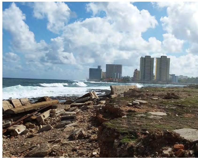
Deben evitarse la construcción de hoteles y edificios cerca de la línea costera, Vedado, La Habana. © Dr.C. Orestes Valdés Valdés. MINED, Cuba, 2019.
