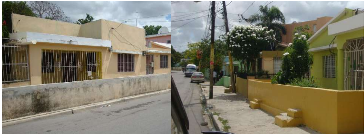
Foto 1. Muros frente a las propiedades en San Pedro para protegerse de las inundaciones. Fuente: ICF.
