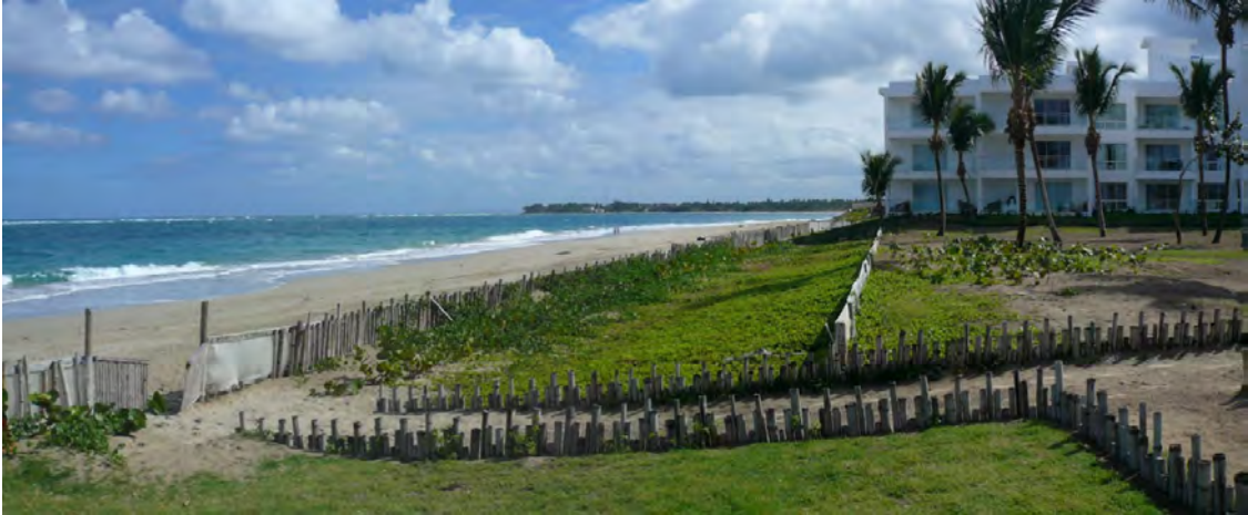
Figura 37, Instalación de trampas de arena en la playa de Goleta
