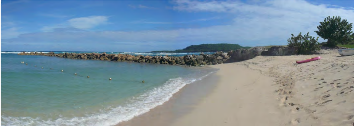
Figura 8. Creación de espigones en playas artificiales y construcción del sistema dunar. Playa Luperón.
