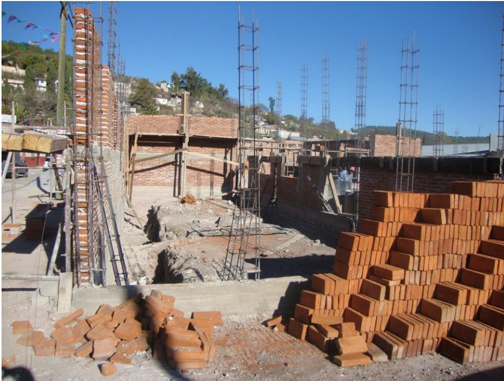
Figura 7. Materiales de Construcción (Obra Civil). Muestra de algunos materiales de construcción, entre ellos acero, ladrillos, madera, etc. Fuente: http://3.bp.blogspot.com
