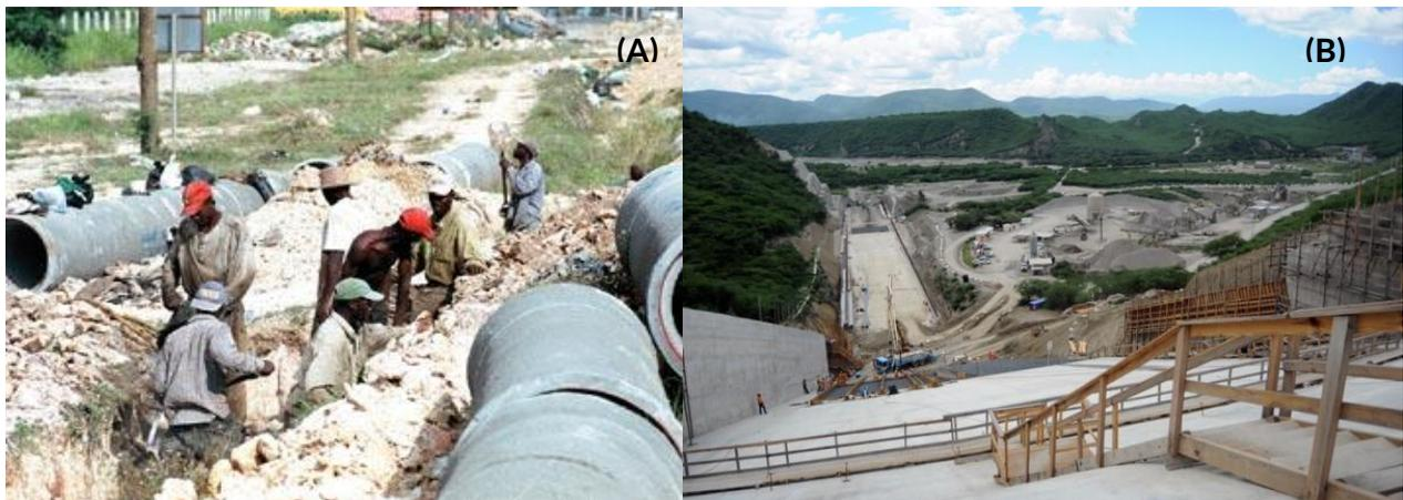
**Figura 4.** (A) Obras del Instituto Nacional de Recursos Hidráulicos (INDHRI) .Degradación del paisaje y almacenamiento inadecuado de materiales (B) Degradacion del paisaje y destrucción de la flora existente por la Construcción de presa de Monte Grande (Barahona) **Fuente:** NoticiasSIN.com 2014
