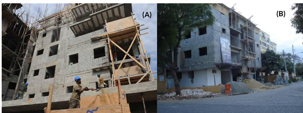
**Figura 3.** (A) Construcción Torre de apartamentos Distrito Nacional. Manejo inadecuado de material granulado. Ausencia de malla de protección (B) Construcción de apartamentos en zona Residencial Santo Domingo Este. Almacenamiento inadecuado de materiales y residuos. Falta de protección a la flora existente. **Fuente:** Creative Commons 2014
