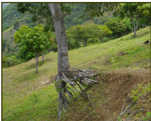
Las raíces de los árboles son testigos de la importancia de la erosión en esta vertiente.
