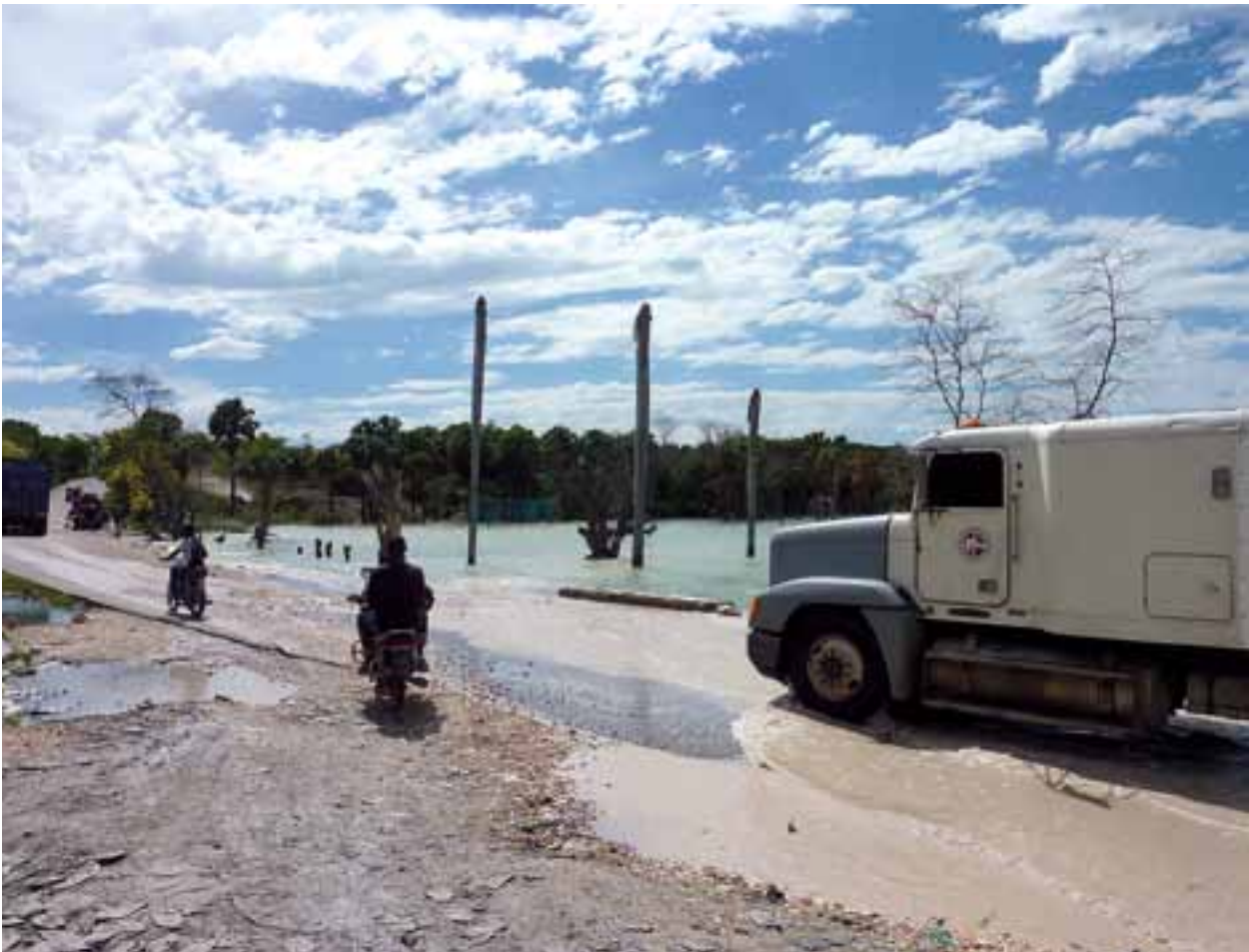
La route principale reliant Port-au-Prince à Saint-Dominique a été surélevée à plusieurs reprises le long des berges du lac Azuei. Cette solution ne peut cependant qu'être temporaire car le niveau des eaux du lac continue de monter.
