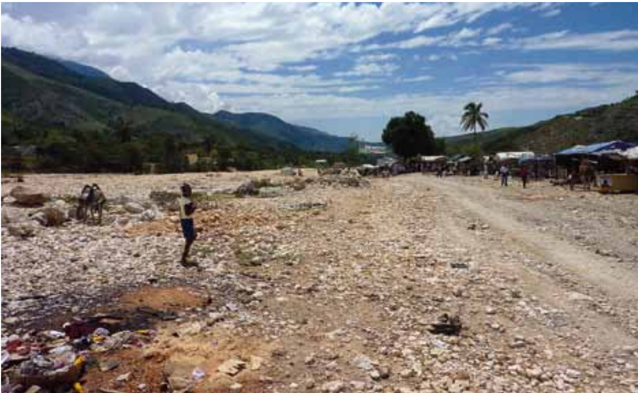
Les signes de la destruction causée par les crues soudaines de 2004 sont encore visibles le long des berges de la rivière Soliette/Arroyo Blanco près de la ville haïtienne de Fonds-Verrettes.
