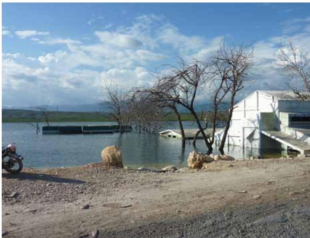
Des investissements ont été réalisés au cours des cinq dernières années pour offrir à Haïti des locaux modernes des douanes et de l'immigration le long de la route principale reliant les deux pays. Ils sont actuellement hors d'usage car ils ont été partiellement submergés à cause de la montée du niveau des eaux du lac Azuei.
