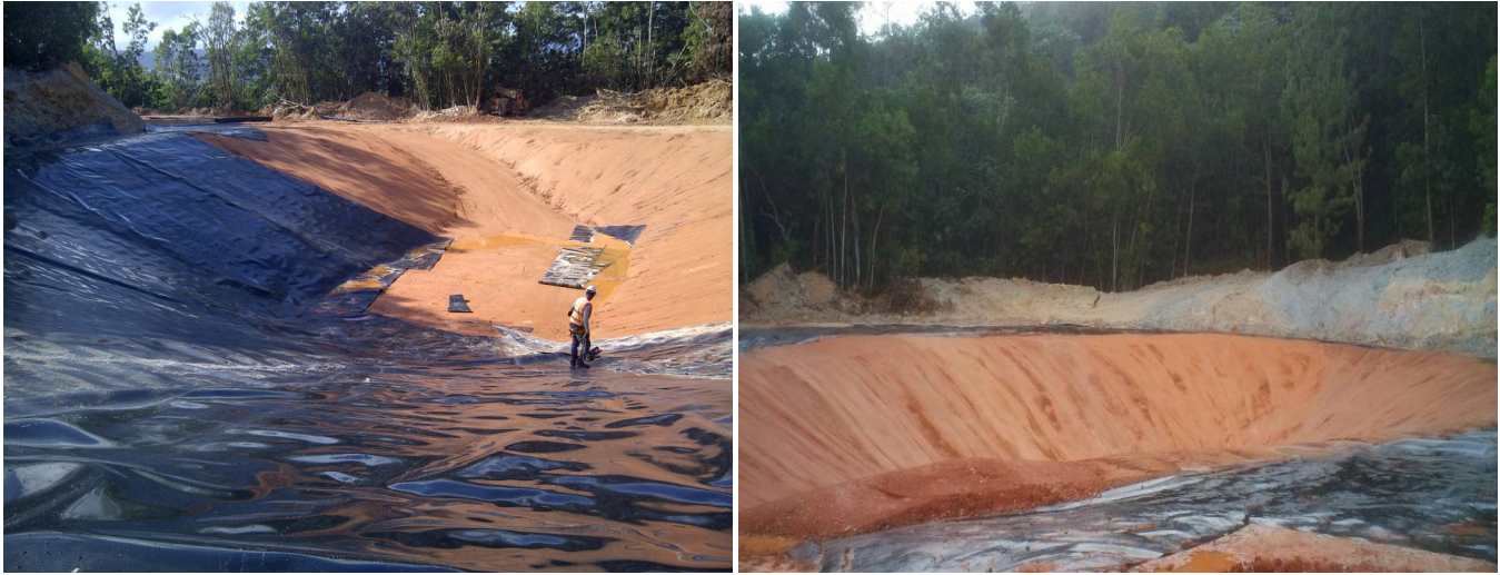
Figura 19 Celda de mercurio soterrada en Barrick Gold
